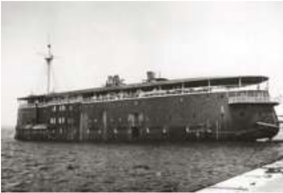
Il Buttafuoco ripositionato a Taranto dopo i lavori di sistemazione a nave alloggio per gli equipaggi del GrupSom 4, immagine probabilmente del 1940.
