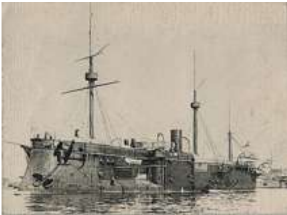
Lo Erzherzog Friedrich dopo i grandi lavori del 1880, come mostra la velatura che appare ridotta rispetto a quella mostrata dopo il varo.
