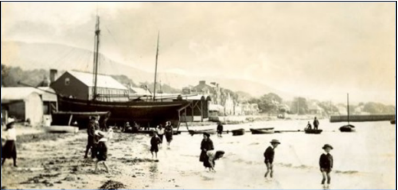
1807. Il cantiere Fife sul Clyde.
