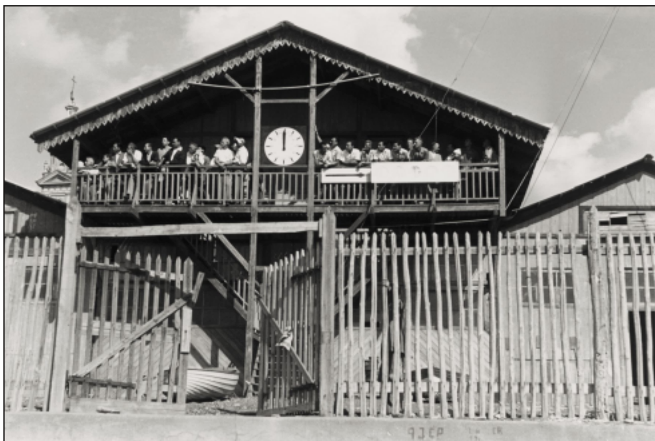
Il Palco giuria allestito negli uffici del Cantiere Costaguta a Genova negli anni Quaranta.
