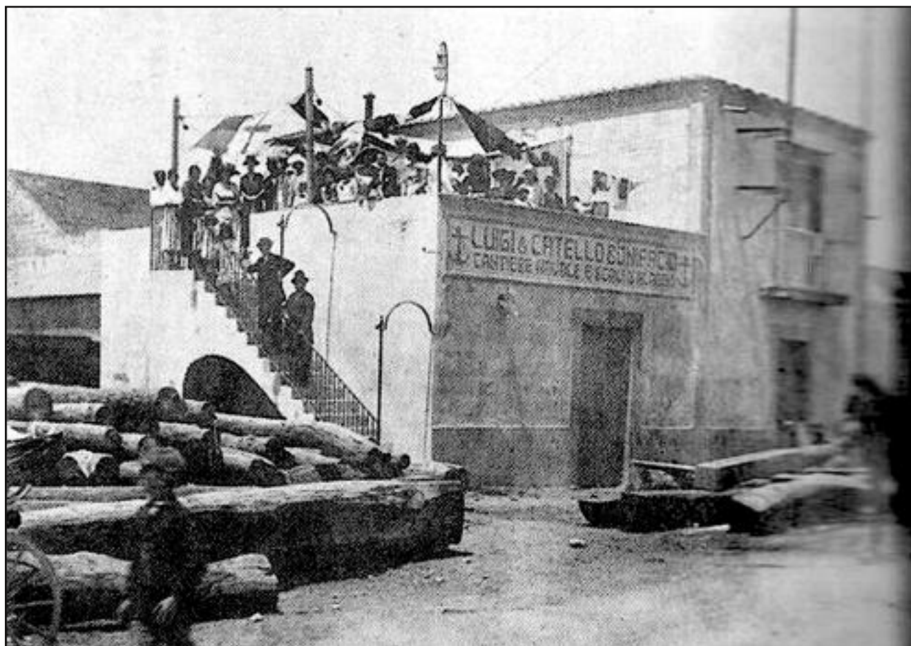
Castellammare di Stabia primi '900. Il cantiere dei fratelli Luigi e Catello Bonifacio.
