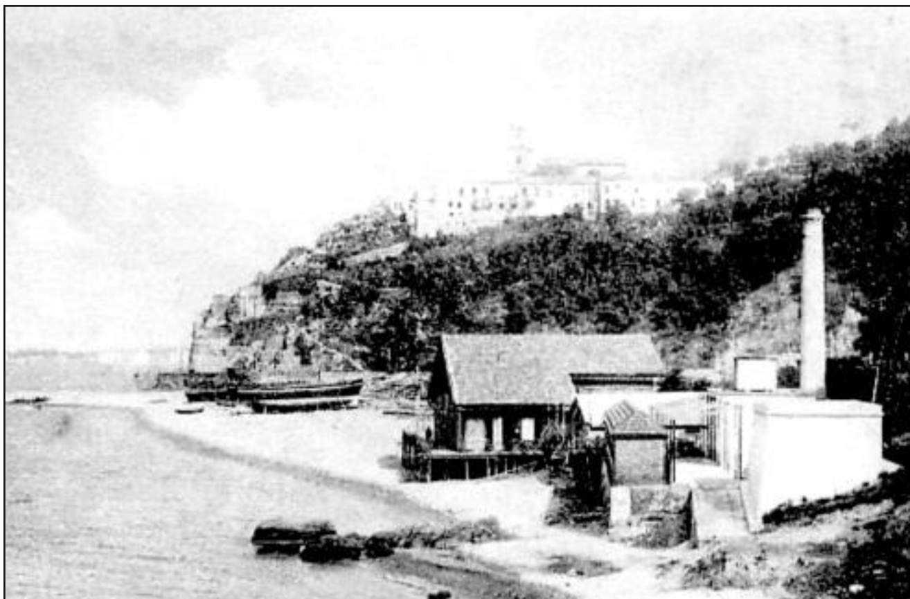
Cantiere sulla spiaggia di Pozzano. Foto fine sec. XIX. Collezione autore.
