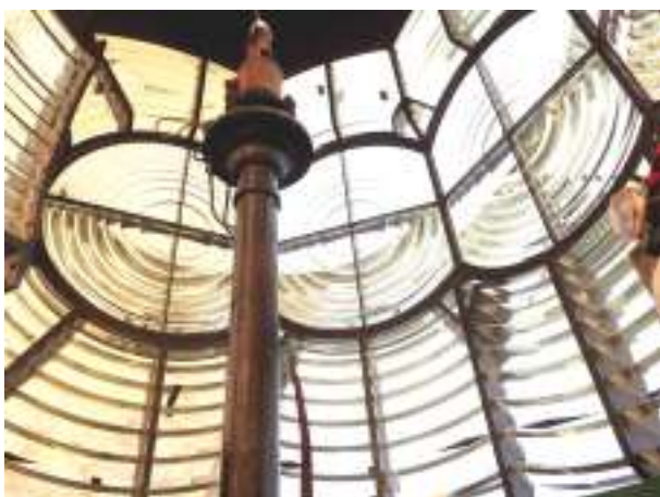
Elbow Reef - la grande lente del 1° ordine con al centro la testa del bruciatore
