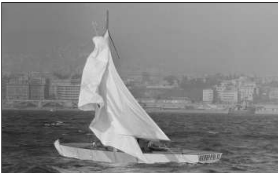
Foto 10 - 1963 Rottura dell'albero per "Guappa II" questo genere di incidenti erano frequenti prima dell'introduzione degli alberi in lega leggera nel 1967
