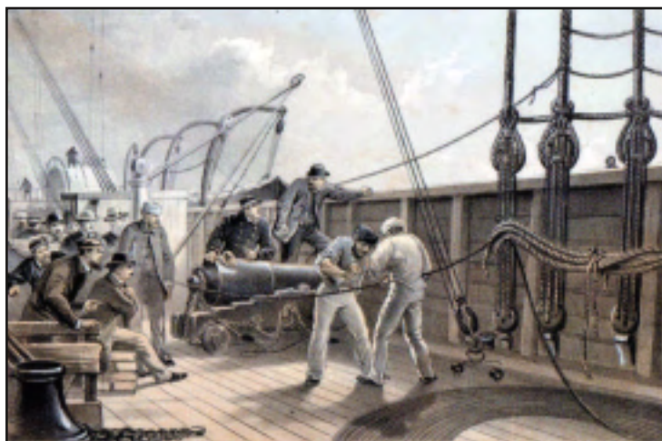
Attività di giunzione del cavo danneggiato - 25 luglio 1865.
