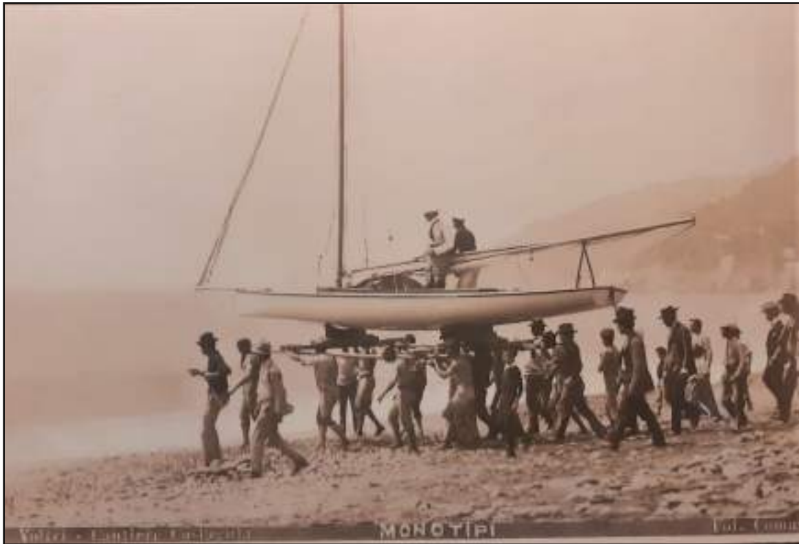
Foto 4 – Varo di un monotipo della spiaggia con la portantina “a scàella” in uso per consentire il varo anche con mare mosso, l’equipaggio era già imbarcato pronto a manovrare si noti l’armatore con la camicia inamidata e i polsini!
