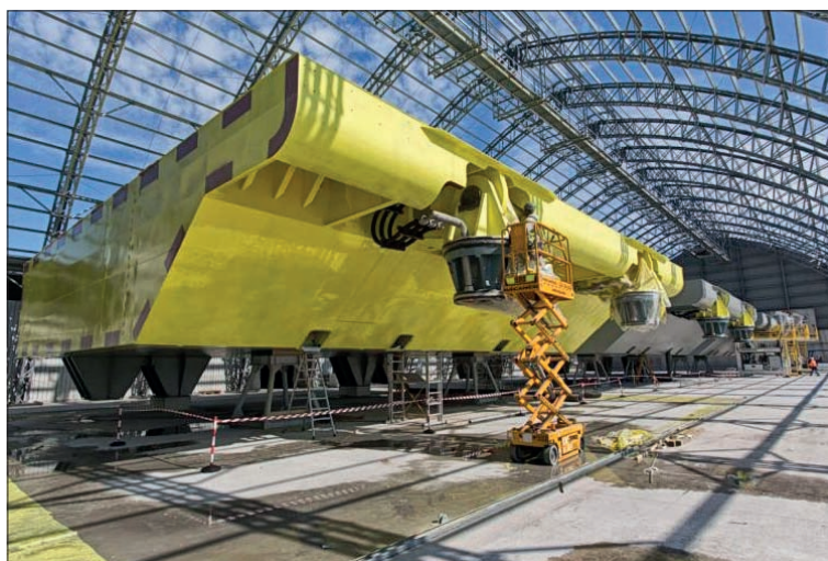
Le grandi paratoie del MOSE in allestimento lungo la linea di montaggio
