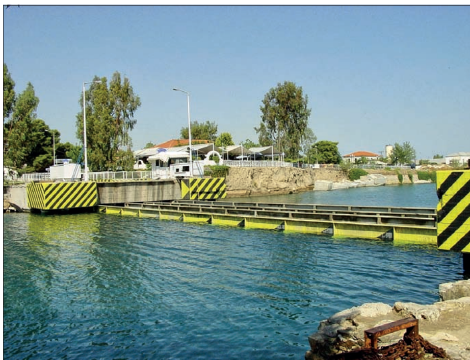
Il ponte sommersibile di Poseidonia, posto all'imboccatura nord - ovest del canale di Corinto
